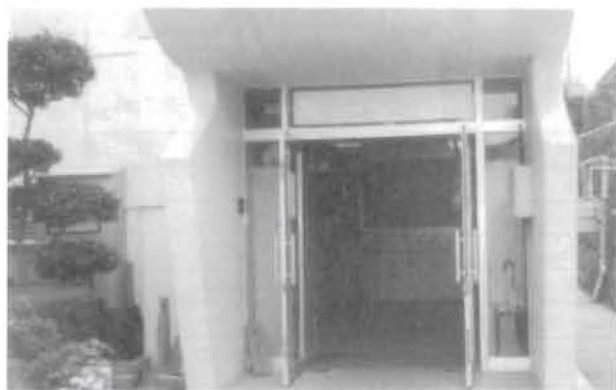
同窓会棟（3階建1階部分） 玄関写真
